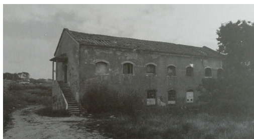
Cerca de S. Pedro antes da demolição, c. 2000
